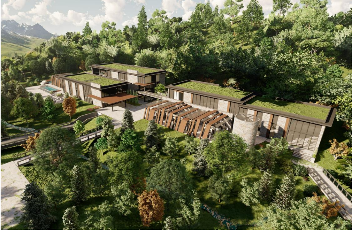
Figura 6.78 Vista general desde sur-oeste del complejo termal Kunugyaku
