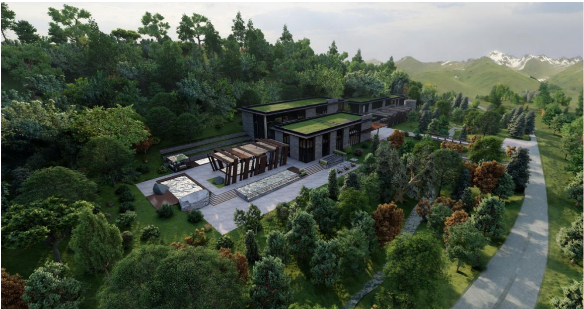
Figura 6.79 Vista general desde sur-este del complejo termal Kunugyaku
