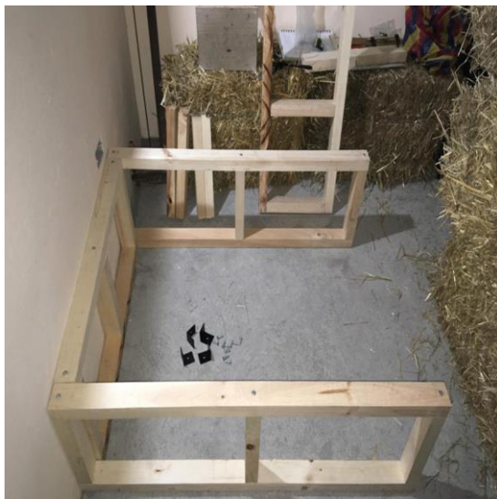
Figura 39: Unión de escalerillas laterales con superior.
