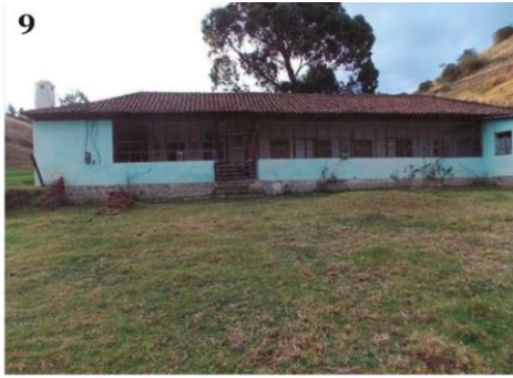
Ubicación: Columbe, Columbe Chico Descripción: Construida en la época republicana en el segundo cuarto del Siglo XX, caracterizada por la utilización de materiales propios del sector para su ejecución.
