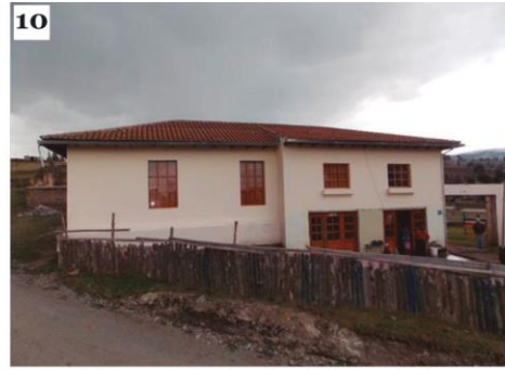
Ubicación: Columbe, Balda Lupaxi Bajo Descripción: Construida en la época republicana, en el primer cuarto del Siglo XX, caracterizada por la utilización de materiales propios del sector para su ejecución.
