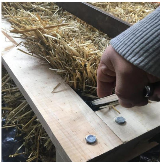
Figura 43: Fijación de escalerilla inferior. Fuente: (Sagñay, 2024)
