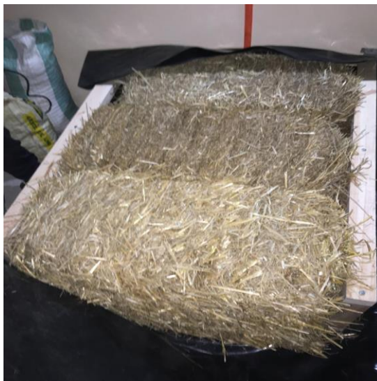
Figura 41: Colocación de fardos de paja.
