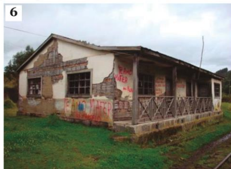
Ubicación: Santiago de Quito, Lupaxi Chico Descripción: Construida en la época republicana, en el primer cuarto del Siglo XX, implantada de manera aislada con retiros en sus fachadas, vivienda de una planta de forma rectangular, con 1 patio y 1 corredor.
