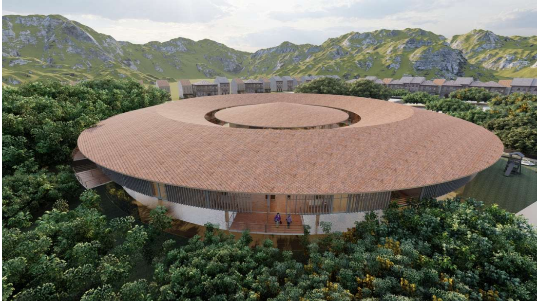
Ilustración 160 Cubierta de la propuesta de ampliación del Centro Gerontológico Municipal de Chambo
