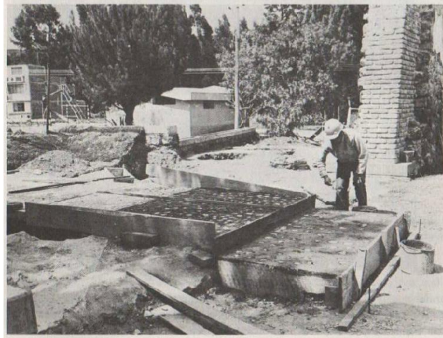
Ilustración 55. Construcción de Caminos internos. Fuente: (Crespo Toral, 1982)
