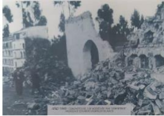
Ilustración 60. Daños por terremoto. Fuente: (Mena Albarracín, 2022)
