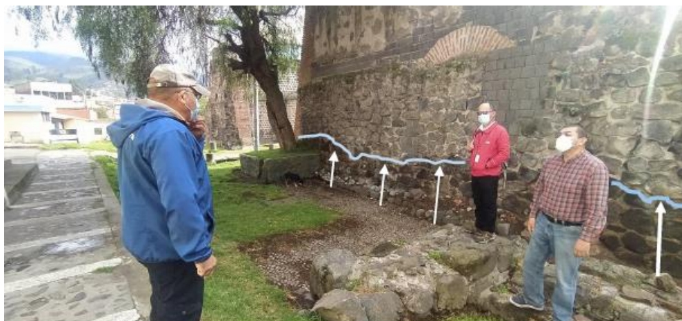
Ilustración 59. Daños por agua. Fuente: (Mena Albarracín, 2022)
