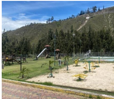
Ilustración 98. Luminarias sin funcionar. Fuente: Elaboración Propia
