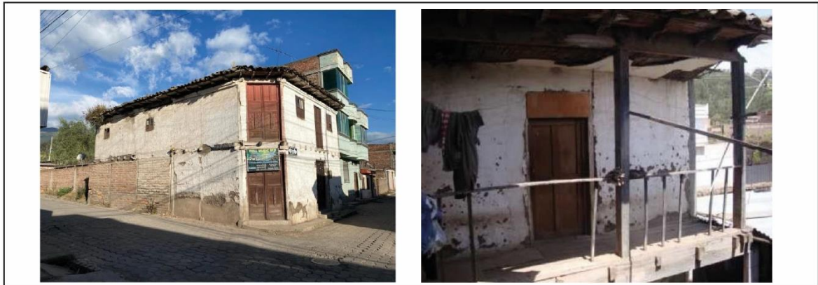
Descripción de la fotografía: IMÁGENES DE LAS FACHADAS LATERALES Y LA PARTE INTERIOR.
