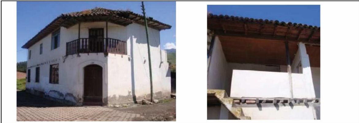
Descripción de la fotografía: IMÁGENE DE LA VISTA DE LA ESQUINA Y DE SU INTERIOR CON LS GRADAS..
