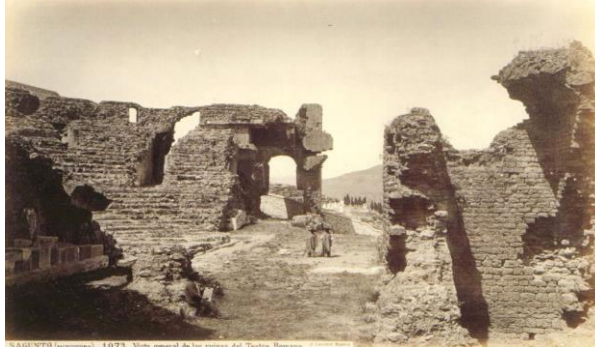
Figura 39. Ruinas del teatro Romano de Sagunto 1870
