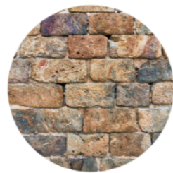
Muros de piedra patrimonial de la Iglesia San Lorenzo de Sicalpa.
