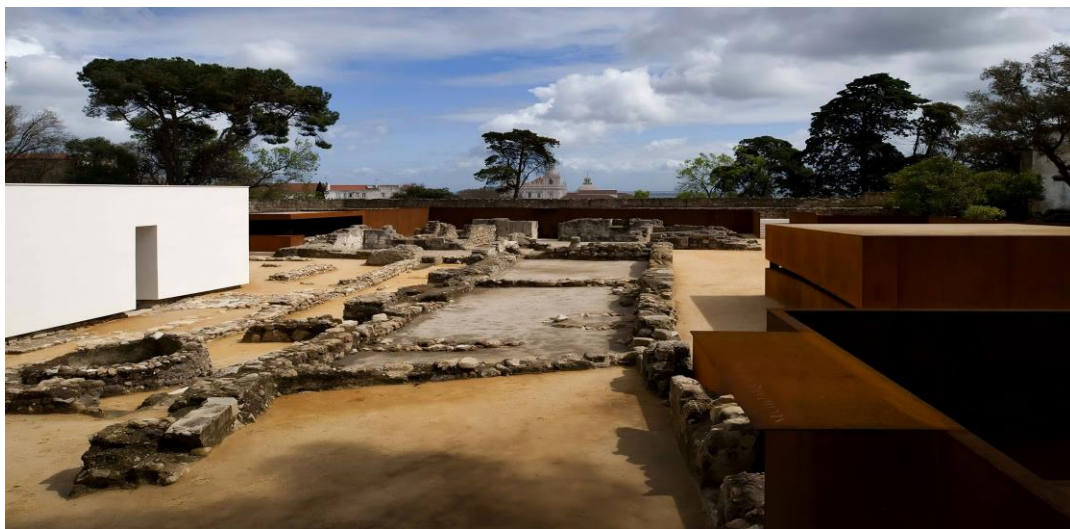
Figura 15. Estado de las ruinas después de la intervención
