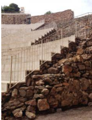
Figura 46. Evidencia arquitectura nueva sobre arquitectura antigua
