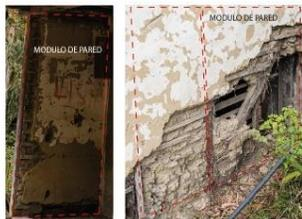
Conformados por unidades de albañilería de Bahareque embutido, elaborados en el sitio con una estructura y entramado de madera, rellena con una mezcla de barro, paja y agua y un enlucido de barro, la vivienda conforma un perfil Rural uniforme con dos niveles, se utilizan dinteles de madera encima de los vanos y su predominio es del lleno sobre el vacío, también posee divisiones de muros de madera.
