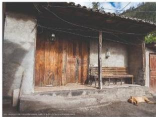
Se conforma un plano que se eleva sobre el nivel del suelo, a fin de compensar la pendiente propia del terreno y lograr horizontalidad. Presencia de columnas de madera que forman un portal que remarca el acceso a la vivienda. Se rompe la continuidad del espacio debido al volumen agregado.
