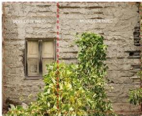
Conformados por unidades de albañilería de Bahareque embutido, elaborados en el sitio con una estructura y entramado de madera, rellena con una mezcla de barro, paja y agua y un enlucido de barro, la vivienda conforma un perfil Rural uniforme de un nivel en dos bloques, se utilizan dinteles de madera encima de los vanos y su predominio es del lleno sobre el vacío, también posee divisiones de muros de madera y un muro de madera en la fachada principal en el segundo bloque.
