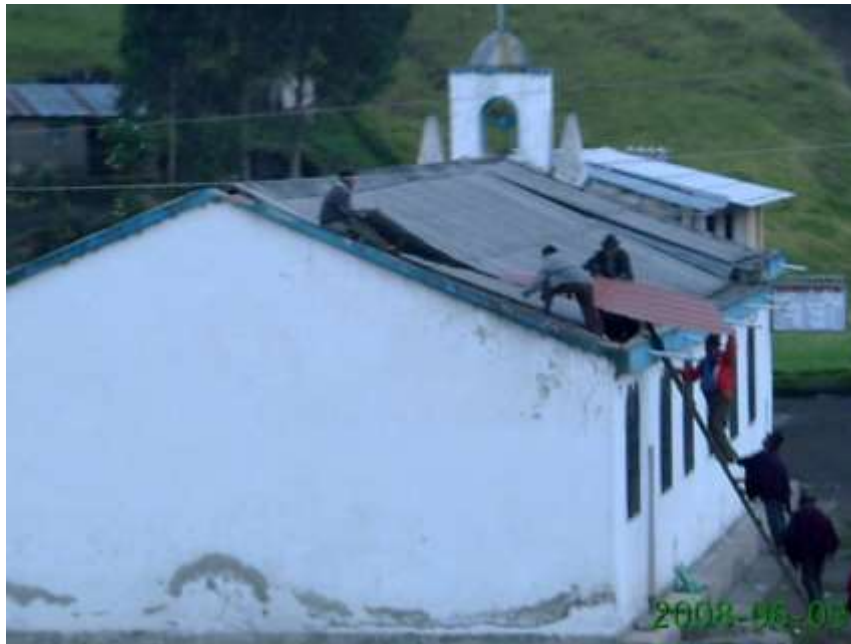
Figura 35: Remodelación de la iglesia Belén en Troje Grande
