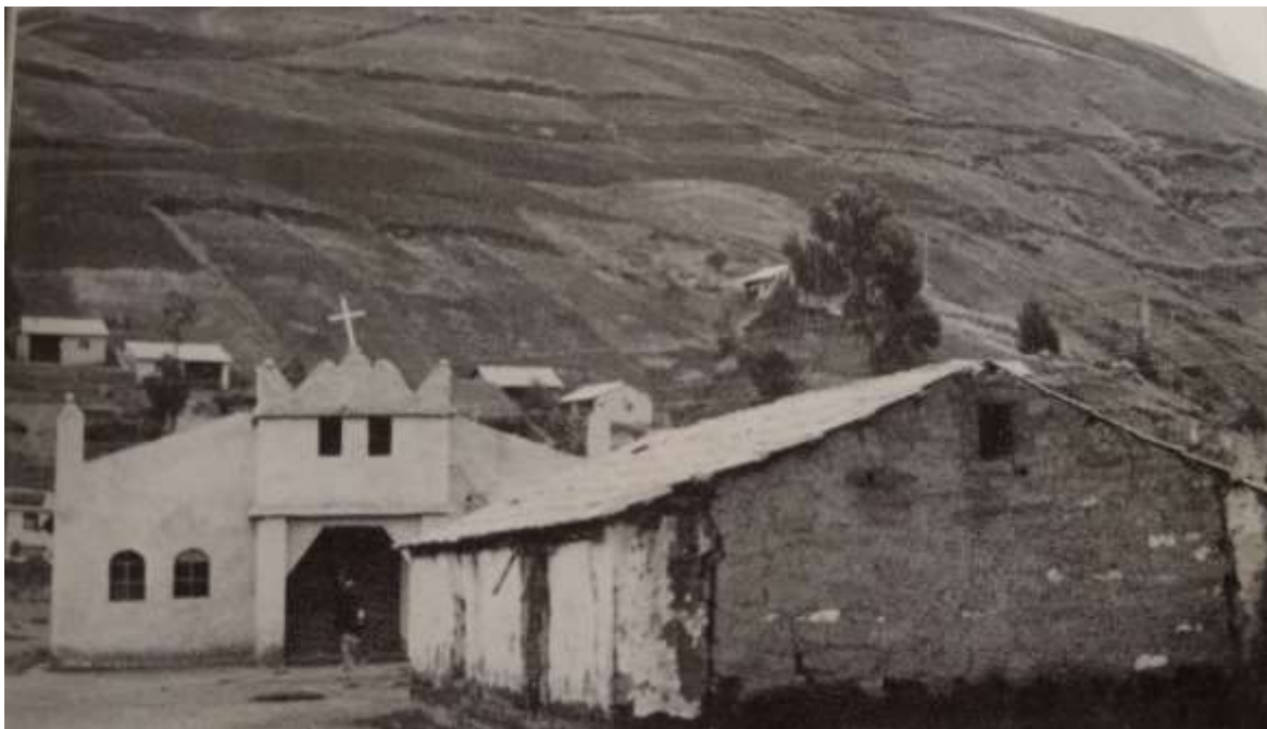
Figura 17: Primera iglesia Belén de Troje Grande
