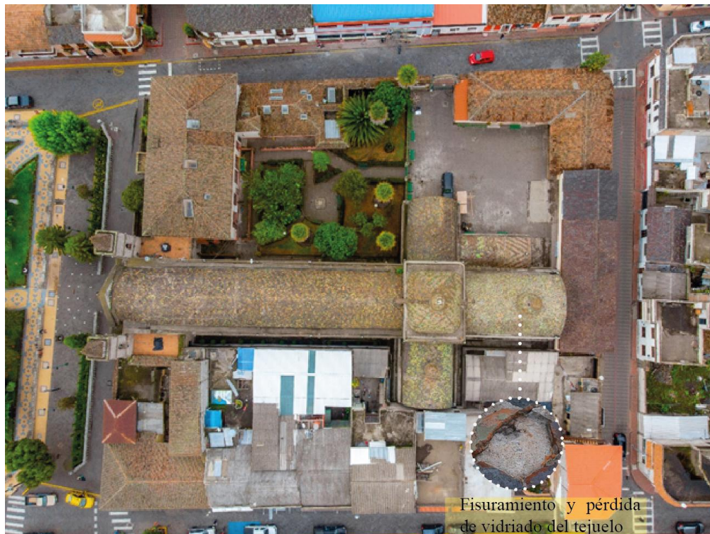
Figura 62. Vista aérea de la iglesia Fuente: Elaboración propia
