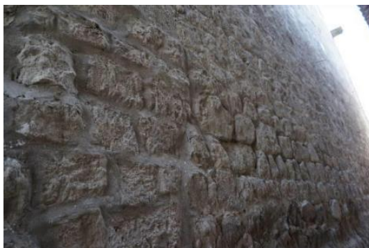
Figura 51. Muro del templo de sillería Fuente: Elaboración propia
