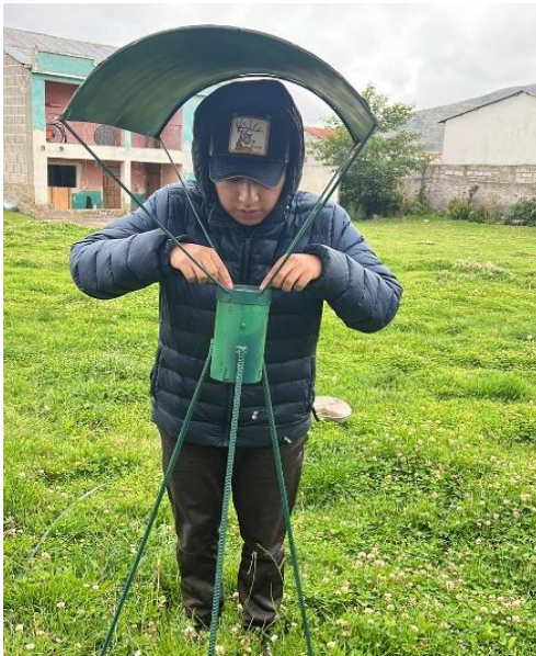
Instalación de Equipos
