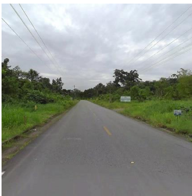
Vía Secundaria Puerto Napo-Ahuano
