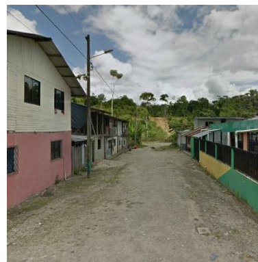
Vía Local Parroquia Pano
