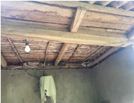
Ilustración 164.- Cubierta de carito y pingos de madera,estudio de vivienda-Caso 2 Fuente:Por testistas
