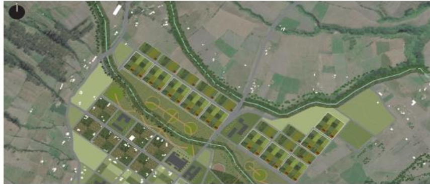
Ilustración 191.-Acercamiento al sitio. Fuente: Elaboración Propia.
