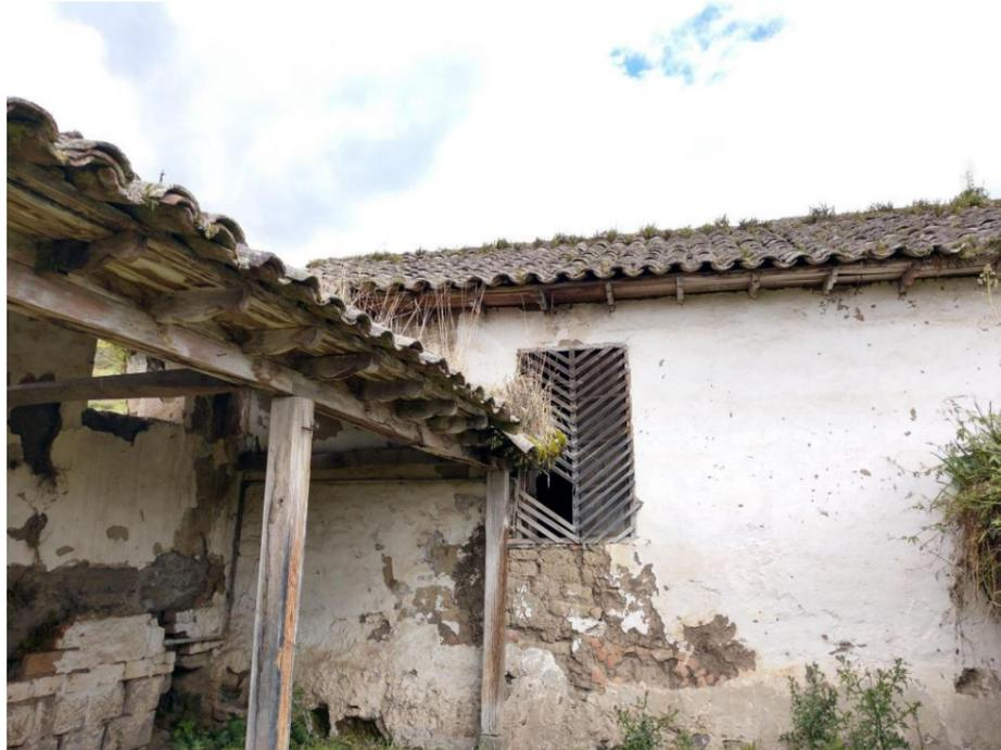
*Figura 44. Estructura de cubierta de teja. Fuente Luis Segovia 2023*
