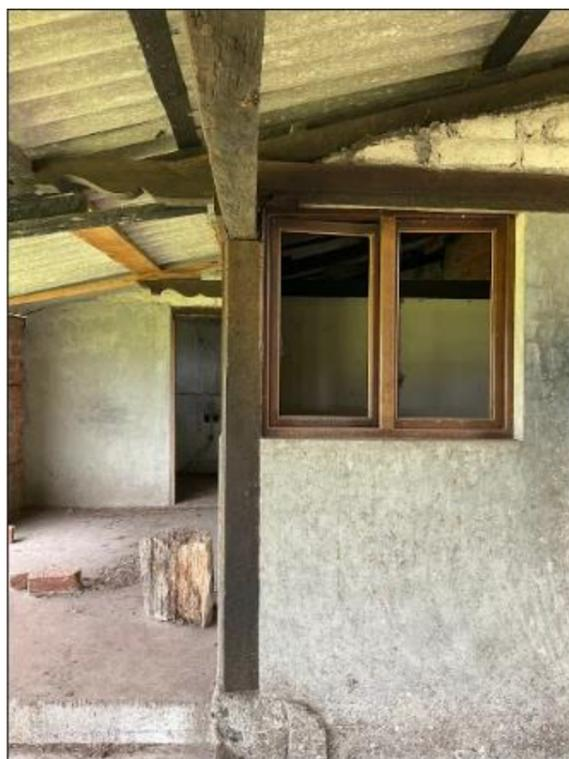
*Figura 26. Construcción de paredes de ladrillo bloque 6 Fuente Luis Segovia 2023*
