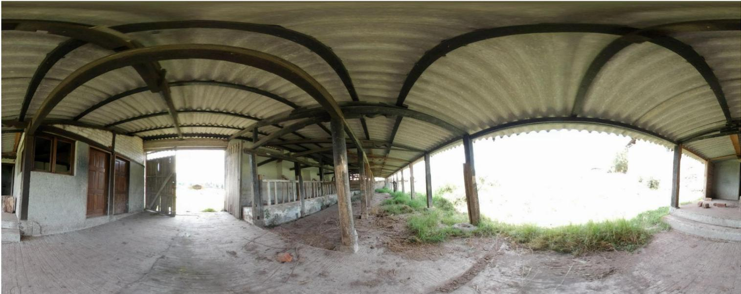
Figura 27. Piso de cemento, estructura de madera, cubierta de Eternit bloque 6 Fuente Luis Segovia 2023
