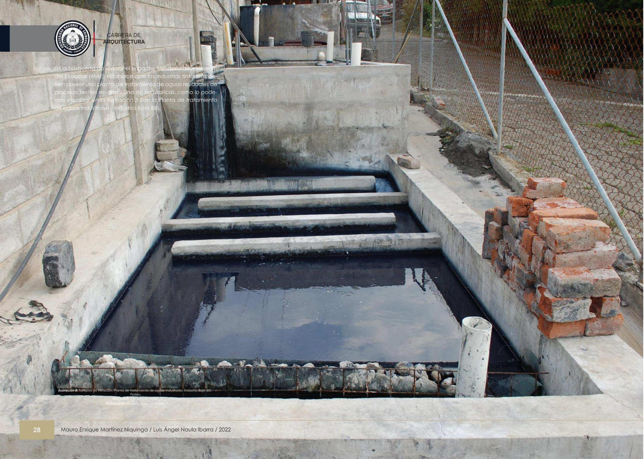
Ilustración 8: Tanques de Filtración, Planta de tratamiento de aguas industriales, Industria Bays Bills - Pelileo.
