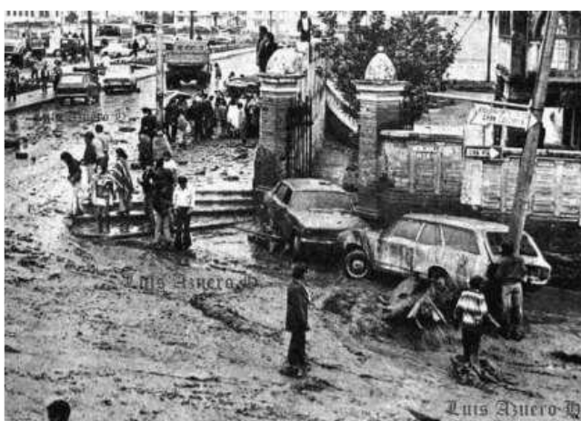
Daños del aluvión de La Gasca en 1975
