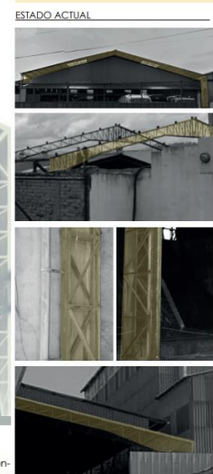
Ilustración 132. Imágenes de la Estructura de la Ecuacerámica Robamba Fuente: Elaboración propia
