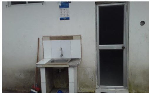
Ingreso a la planta
