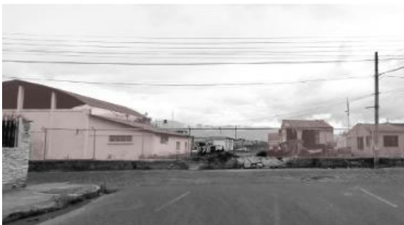
Figura 11. Edificaciones sin uso y en mal estado SENAGUA Fuente: Elaboración Propia
