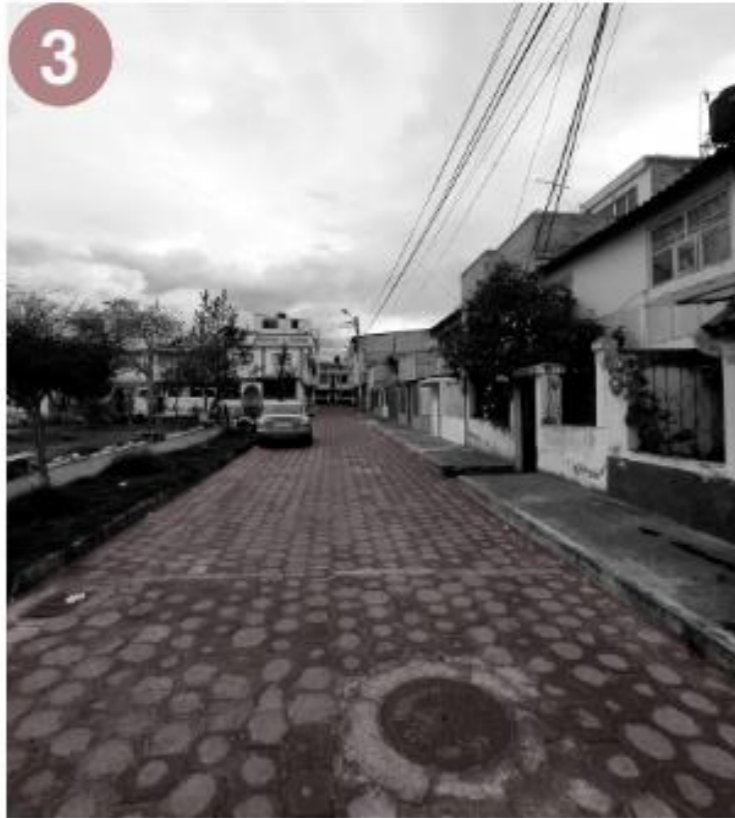
Figura 142: Fotografía de Pasaje 1 Fuente: Elaboración Propia
