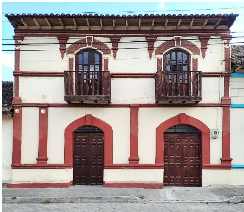
Figura 125.- Fachada actual - Fuente: (Chávez & Vilaña, 2022)
