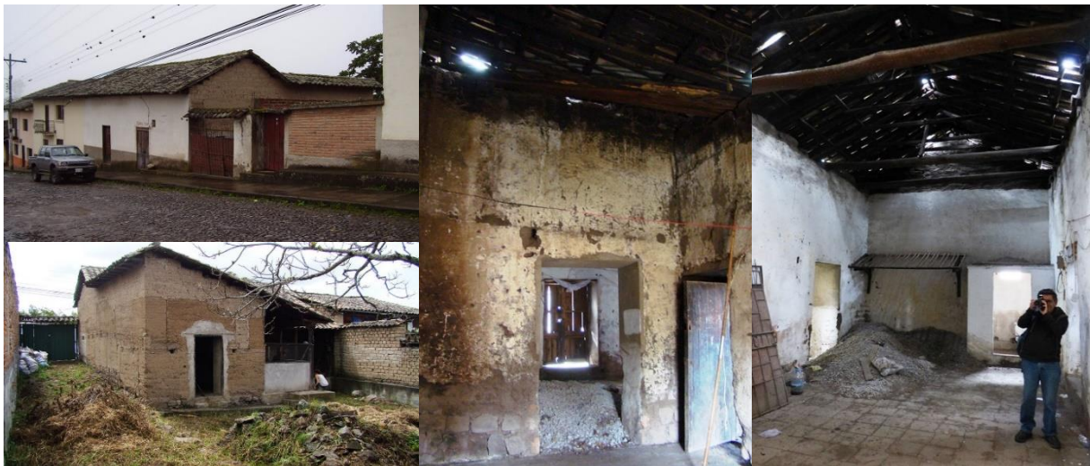
Figura 5.- Estado inicial - Fuente: (BORDE, 2019)
