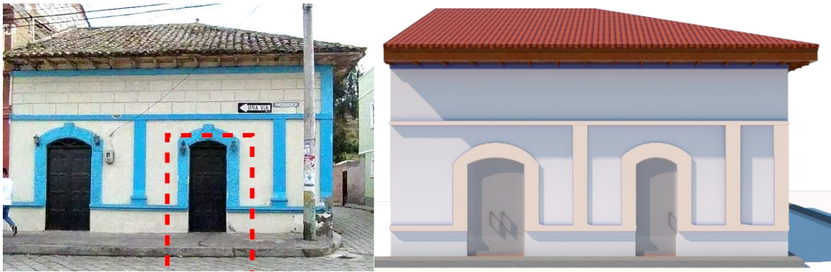
Figura 107.- Mantenimiento de fachadas - Fuente: (Chávez & Vilaña, 2022)
