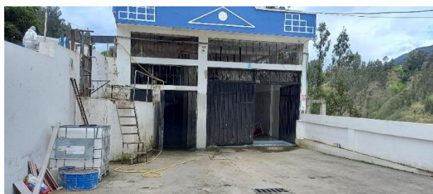
Figura 4 Centro de Faenamiento del cantón Chambo
