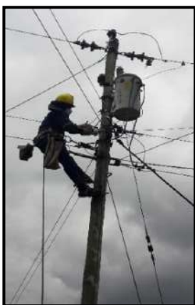
Figura 3. Templado de acometida de 40 metros de longitud en poste de madera tratada
