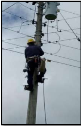
Figura 1. Ascenso y descenso en poste de hormigón circular.
