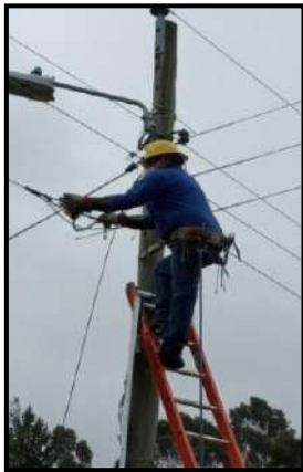
Figura 2. Templado de líneas de BT (Trabajo programado sin energía)
