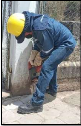
Figura 4. Perforación con rotomartillo en superficie de concreto.
