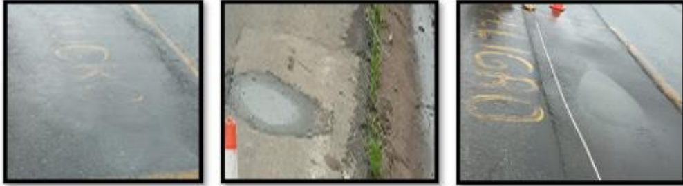
Figura 26: Falla tipo abultamientos y hundimientos de severidad baja, media, alta Fuente: (Chauca & Pomatoca, 2022)
