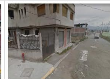
Fig # 2 Acera en mal estado y Hidrante de agua
