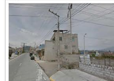
Fig # 3 Poste de luz de y rampa mal estado
