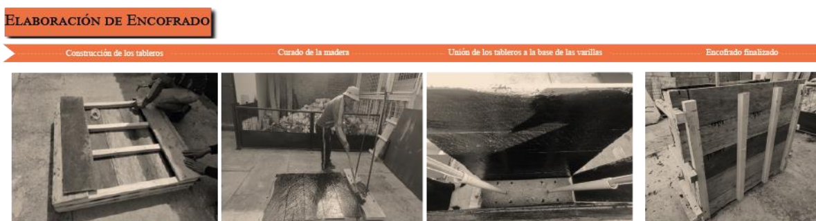
Figura 20: Elaboración del encofrado para el muro 1m x1m de tapial postensado con suelo cemento a escala. Fuente: Pastuña & Vallejo, 2022
