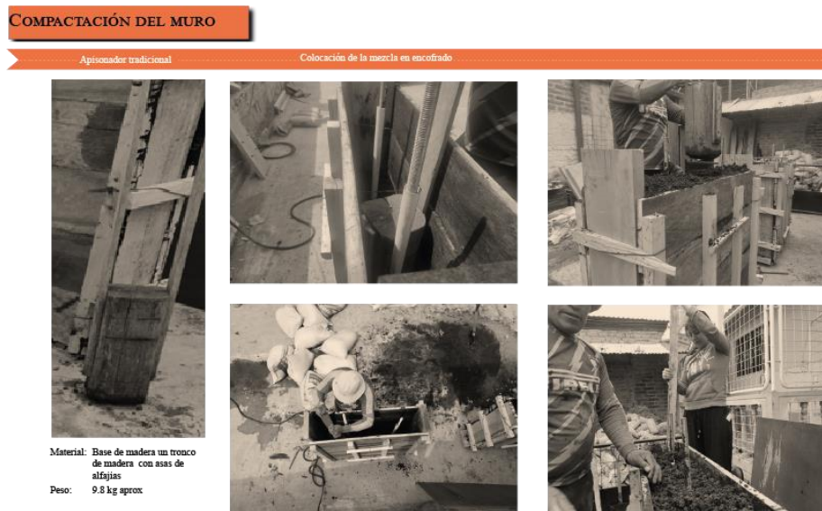
Figura 21: Compactación del muro de tapial postensado con suelo cemento a escala. Fuente: Pastuña & Vallejo, 2022
