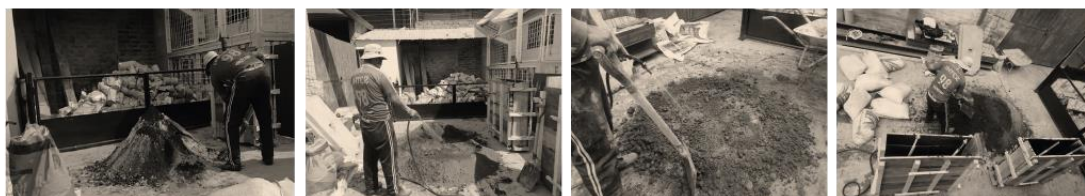
Figura 23: Mezclado del material. Fuente: Pastuña & Vallejo, 2022
