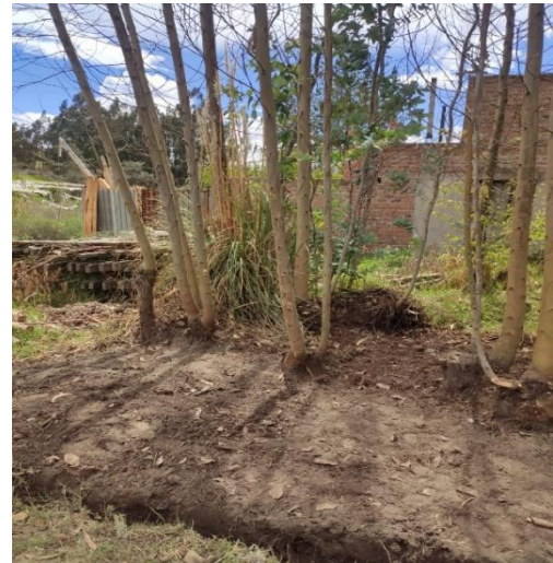
Limpieza del terreno
