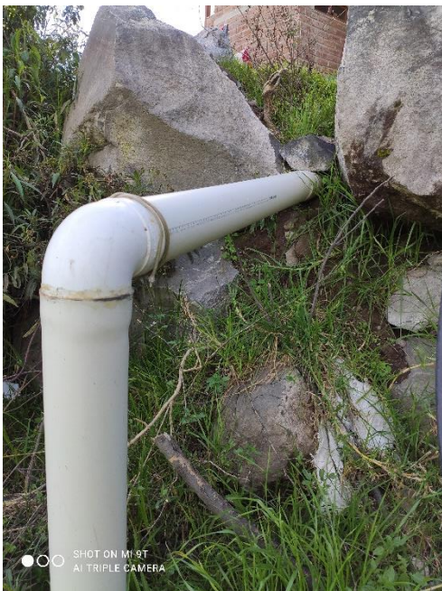
Tubería que conduce el agua residual
