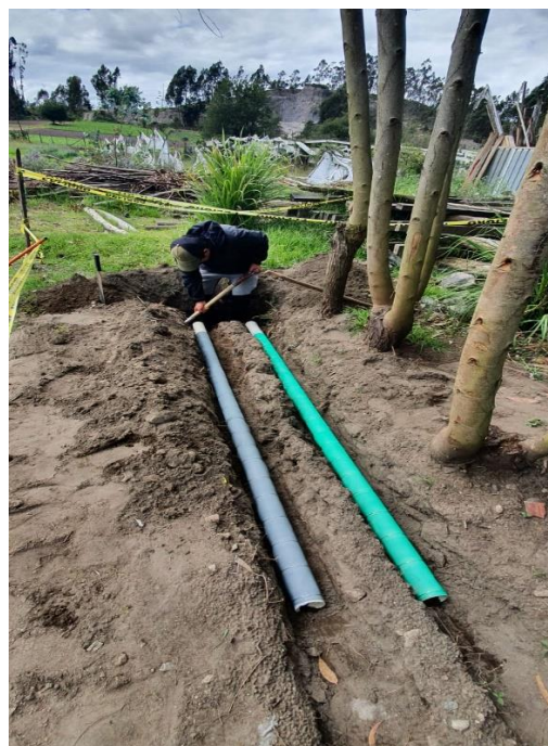
Instalación de tuberías de drenaje
