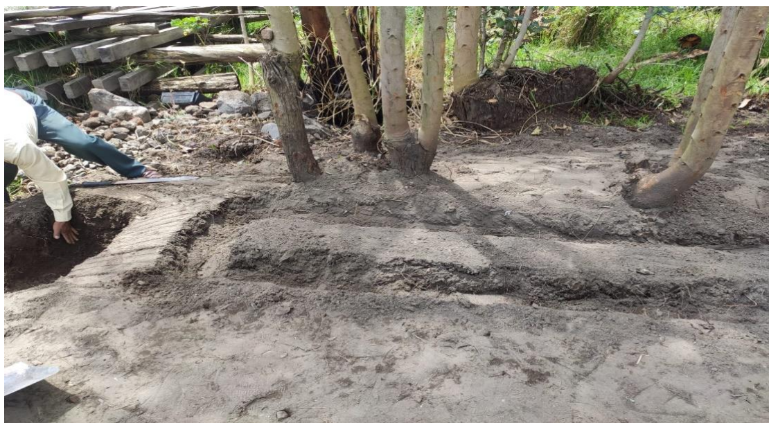
Limpieza final del filtro verde
