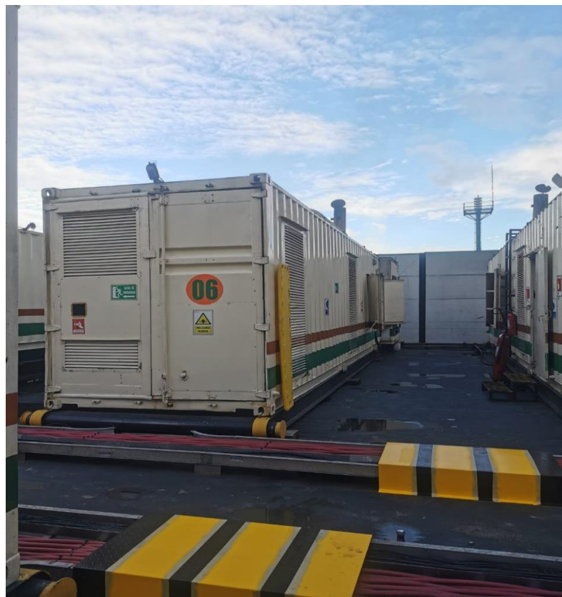
Adecuaciones en pasillos del área de generación
