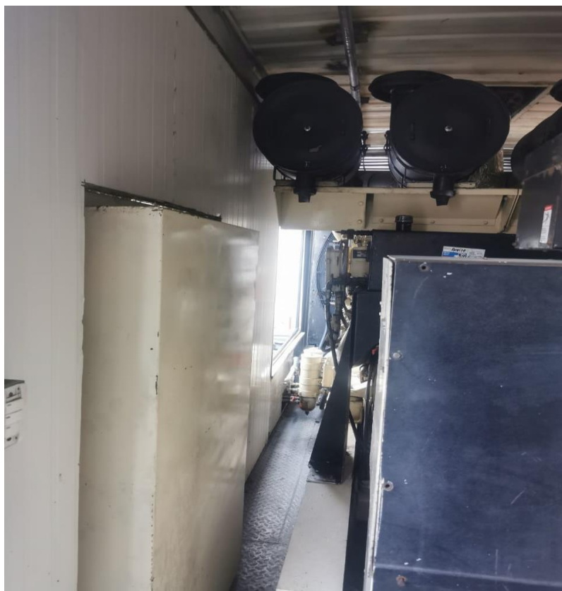
Adecuaciones en la parte interna de las unidades de generación
