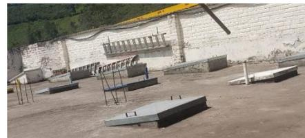
Son entradas empleadas para la inspección y limpieza en la parte superior de los tanques y la vez realizan la función de ventilación.
