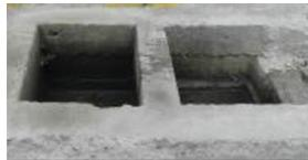
Área destinada para las aguas hidro-carburadas provenientes del área de los distintos surtidores, estas aguas llegan por medio de canaletas.
