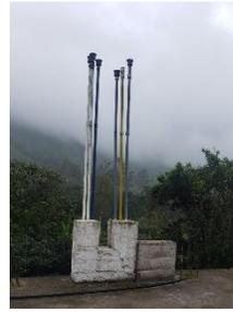
La gasolinera cuenta con 6 tubos de venteo, los cuales son empleados para el desfogue de los tanques de almacenamiento de combustible, cada uno cuenta con campanas de alivio para los gases emitidos por los tanques.
