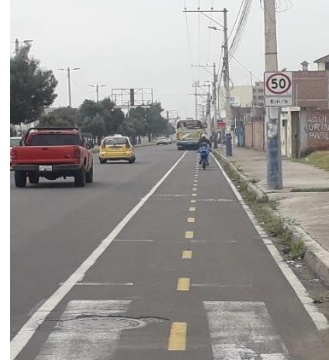
Ilustración 37. Ancho de ciclovía, líneas separadoras, líneas continuas, separadores viales, señaléticas horizontal y vertical de la ciclovía Longitudinal
