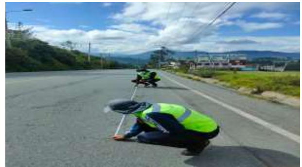
Foto 11 Medición de las fallas de la Vía Chambo
