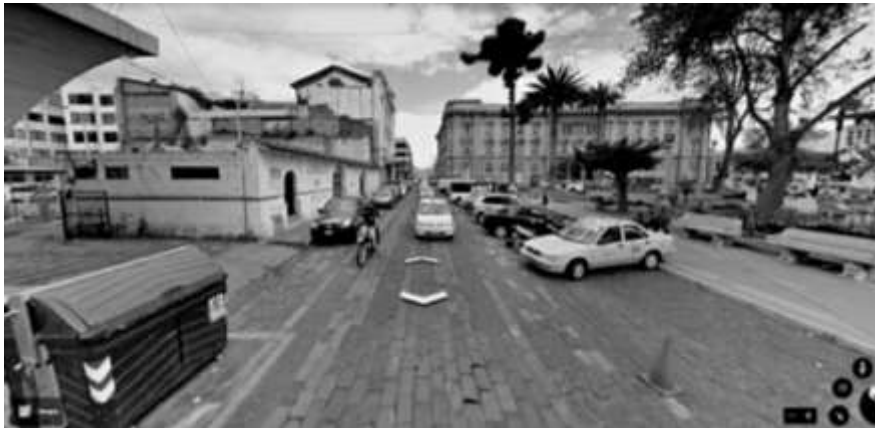
Imagen 66 Estado actual Calle España
