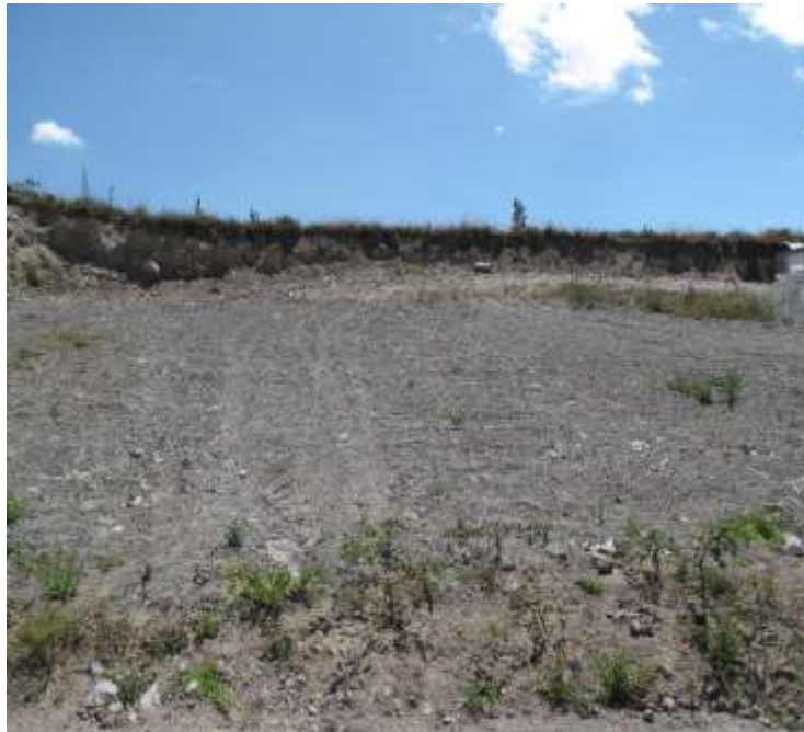
Figura 14 Estado de la Loma 3 con la actual destrucción.
