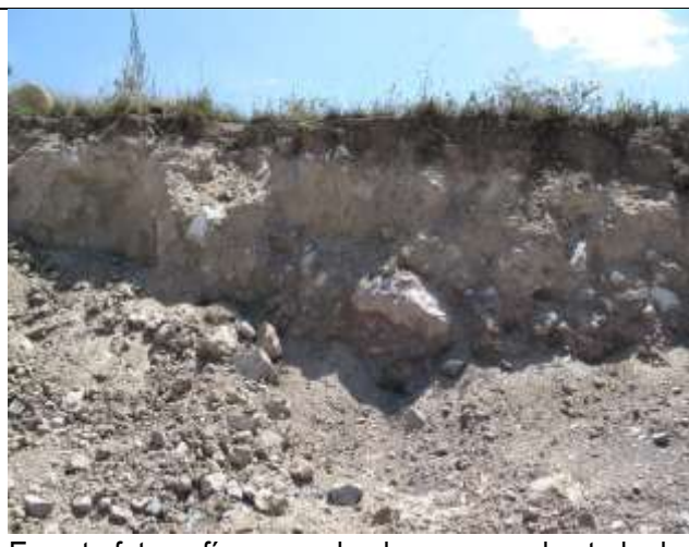
En esta fotografía se puede observar en el estado de destrucción que se encuentra en la loma 3
