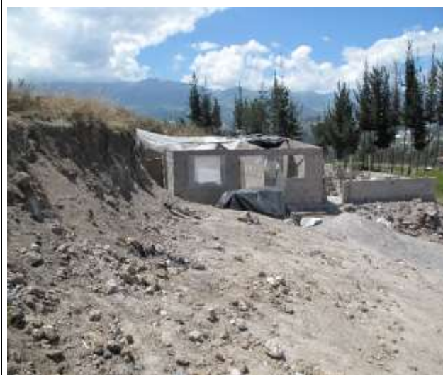
Construcción de una vivienda en la loma 3
