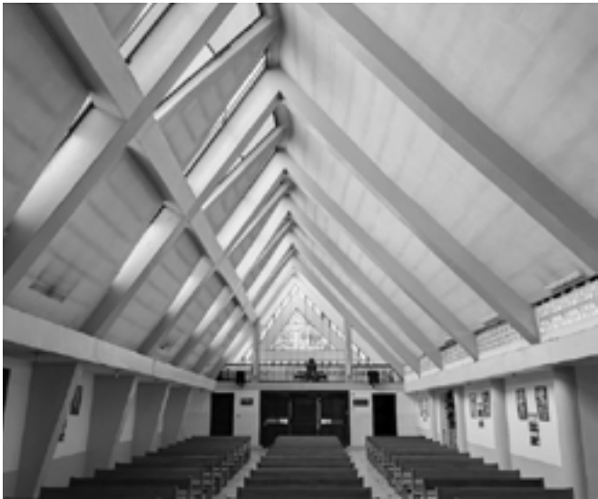
ILUMINACIÓN -VISTA INTERIOR - NAVE + NARTEX
