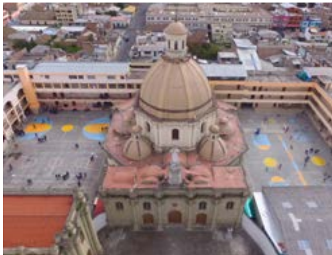
VISTA EXTERIOR - CÚPULA Y COPULINES
