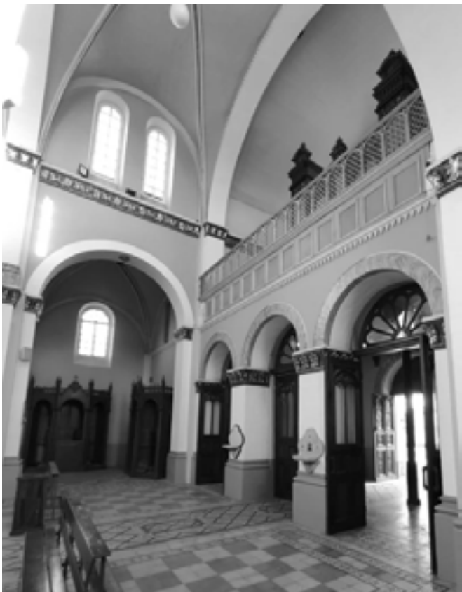
ILUMINACIÓN -VISTA INTERIOR - NÁRTEX + NAVES
