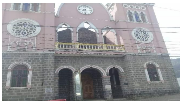
Figura 6. Exterior de la Iglesia San Pedro de Licto
