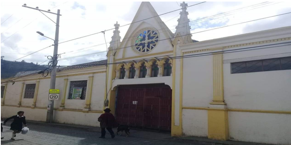
Figura 3. Exterior de la Iglesia San Pedro de Licto
