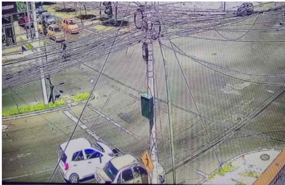
Ilustración 10: Mal estacionamiento. Elaborado por: Calle C, Valdiviezo A.
