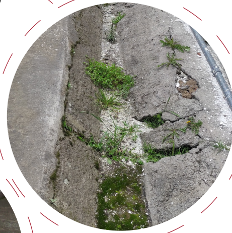
AGRIETAMIENTO EN REVESTIMIENTOS
