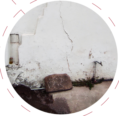
AGRIETAMIENTO EN REVESTIMIENTOS
