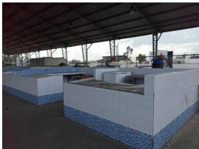
Figura 7: Estado actual del puesto de trabajo.
