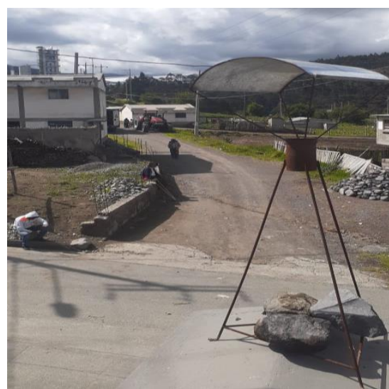
PM 05 Vía principal
