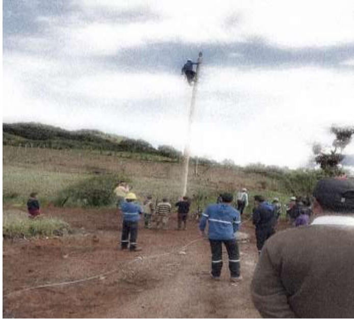
Imagen 13.- Instalación de los postes eléctricos. Fuente: Runacunapac Yachana Huasi (2002)
