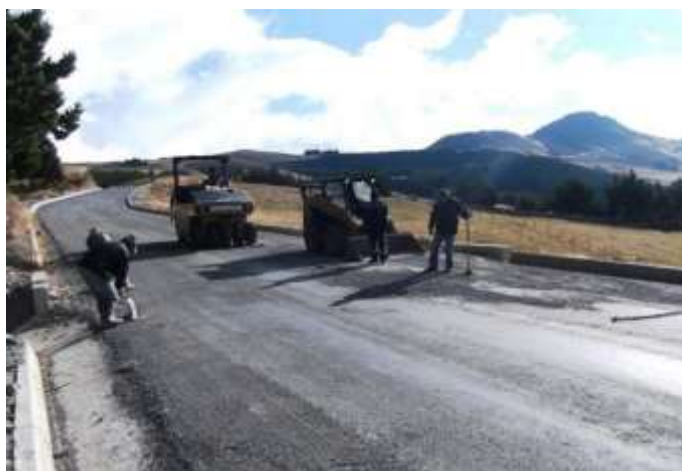
Imagen14.- Pavimentación de la vía Salinas- Simiatug Fuente: Runacunapac Yachana Huasi (2018)
