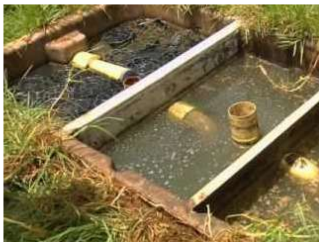
Imagen 15.- Pozo de agua de la comuna de Tahuato. Fuente: Runacunapac Yachana Huasi (2018)
