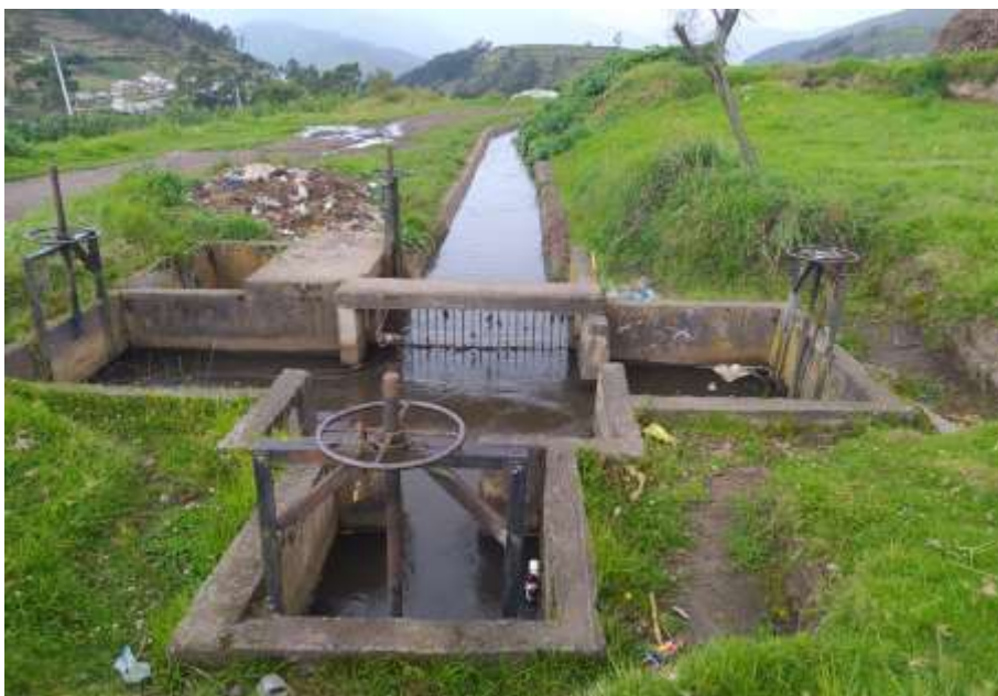
Imagen 8: Ramales de distribución del agua de riego en la comunidad de Cuello Loma Autor: Susana Zavala 2021
