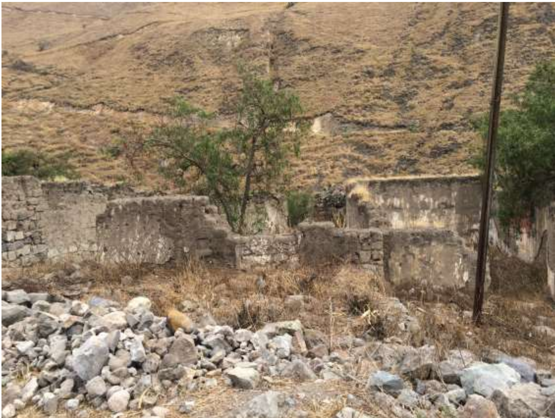
Figura 20. Fotografía Estado Actual. Fuente: Cevallos & Ponce, 2021.
