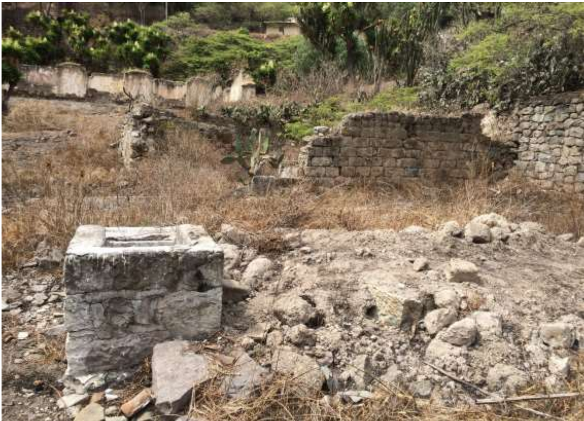
Figura 3. Evidencia del deterioro del La Gerencia de Ferrocarriles. Fuente: Cevallos & Ponce, 2021.
