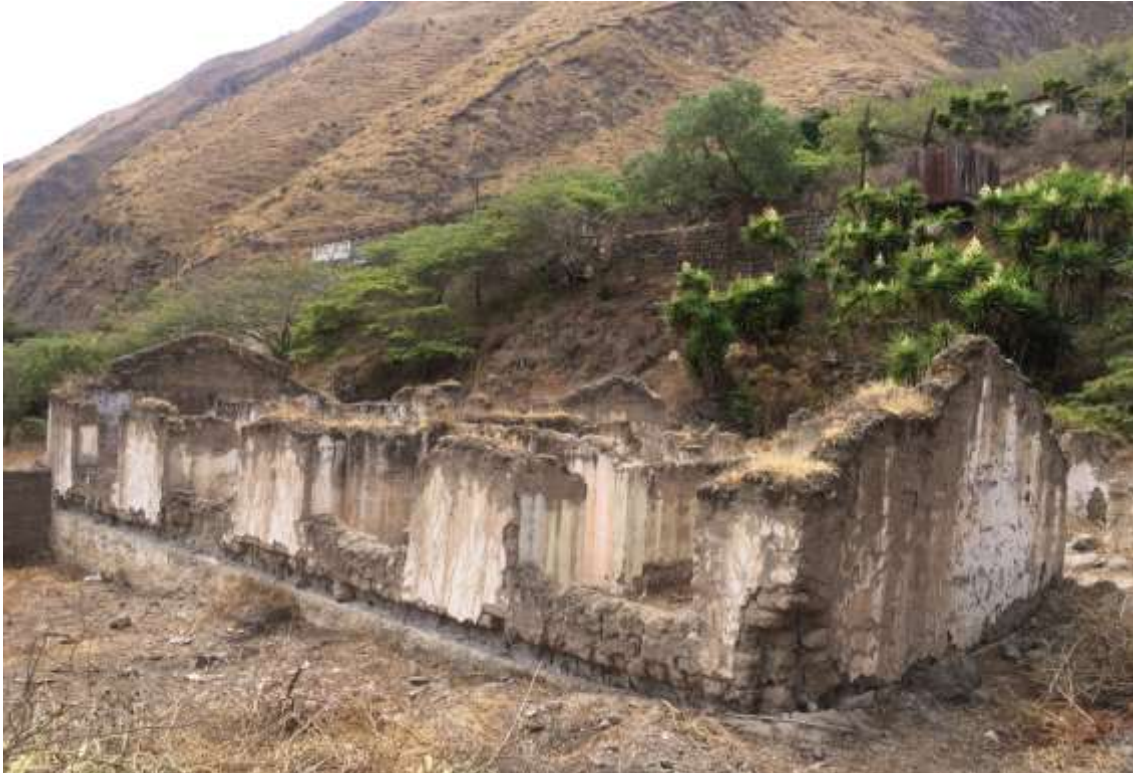
Figura 22. Fotografía del Estado actual 3. Fuente: Cevallos & Ponce, 2021.
