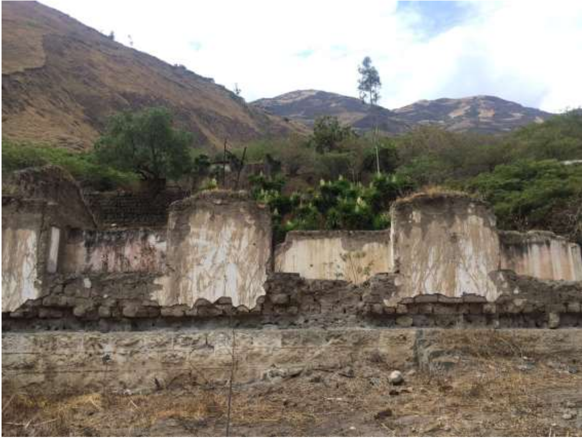
Figura 23. Fotografía Estado Actual 4. Fuente: Cevallos & Ponce, 2021.
