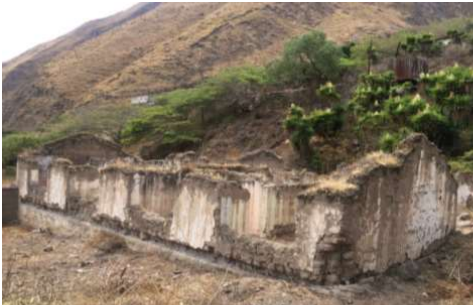
Figura 10. Fotografía del Estado actual 9. Fuente: Cevallos & Ponce, 2021.
