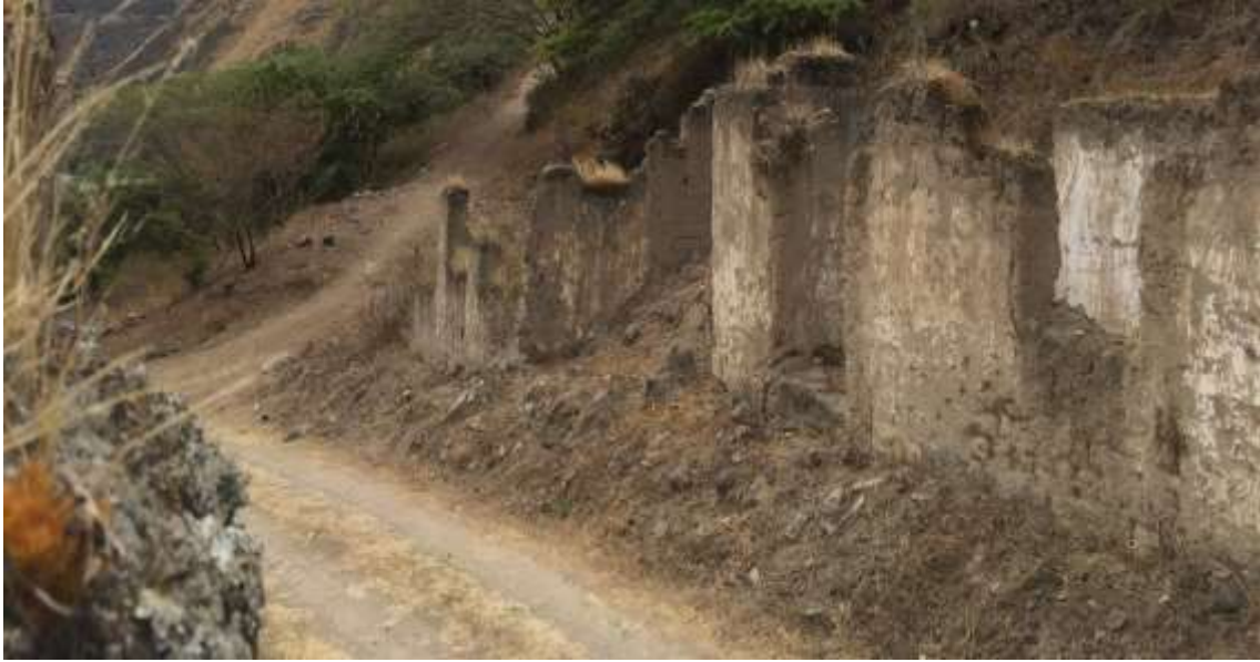
Figura 24. Fotografía del Estado actual 5. Fuente: Cevallos & Ponce, 2021.
