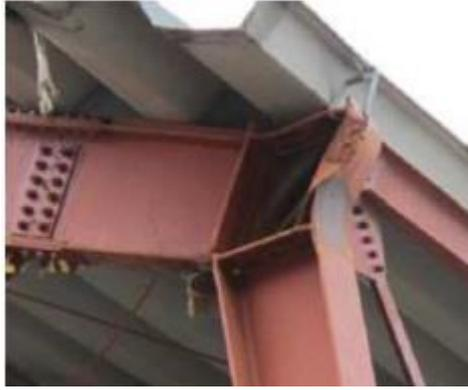
**Ilustración 9:** Deformación excesiva en la zona del panel. **Fuente:** Diseño de conexiones precalificadas bajo AISC para pórticos resistentes a momento.
