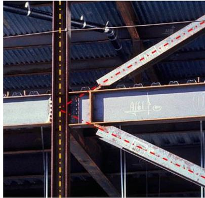
**Ilustración 3:** Detalle del nudo de un pórtico arriostrado con una conexión concéntrica. **Fuente:** Diseño sismorresistente de construcciones de acero.
