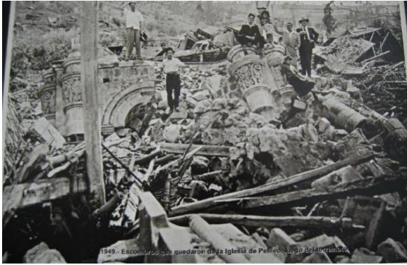
Ilustración 3. Iglesia de la Matriz Destruida por el Terremoto Fuente: “Pelileo Baluarte de Coraje”
