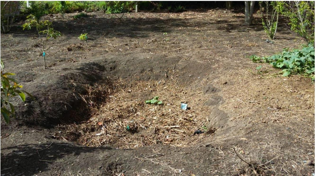
**Ilustración N°4:** Pozo séptico mal elaborado.
