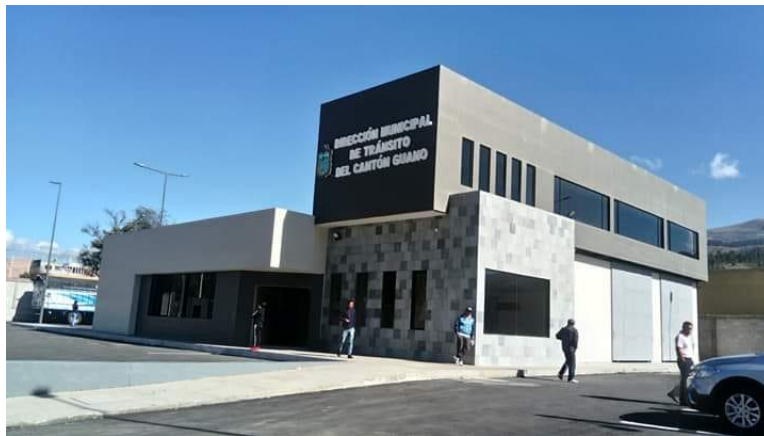
Anexos 1: Dirección Municipal de Tránsito del Cantón Guano
