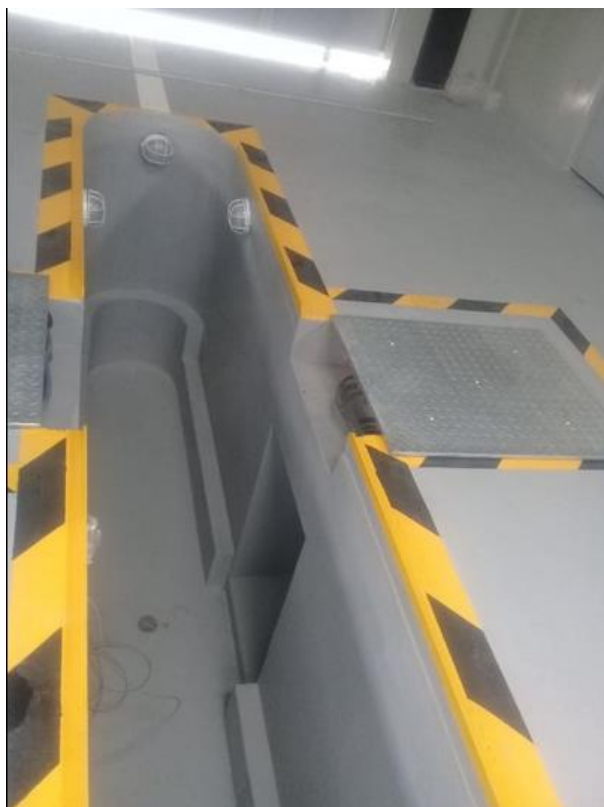
Anexos 16: Fosa de Inspección RTV.
