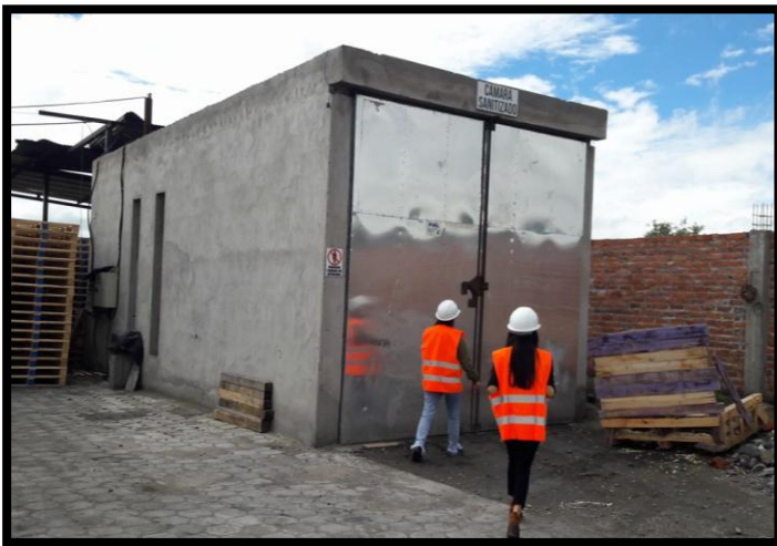
Figura 42. Cámara de Sanitizado
