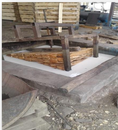
Figura 28. Estanque de tratamiento químico
