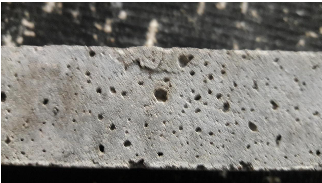
Figura 18 Fisuras en probetas con cemento tipo IP y agregados de Cerro Negro
