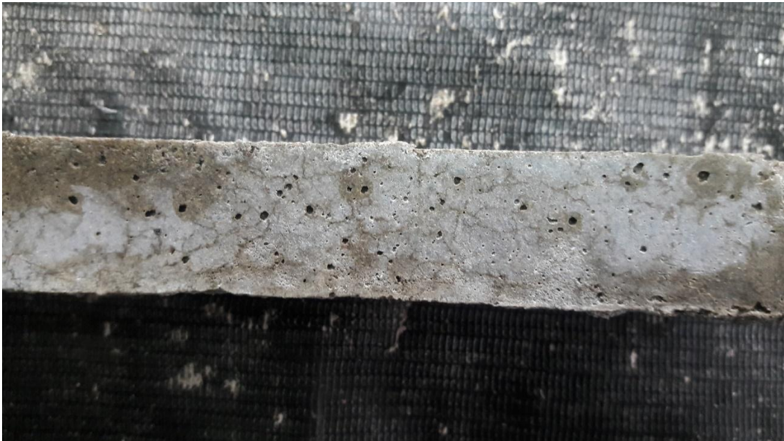
Figura 15 Fisuras en probetas con cemento tipo GU y agregados de Cerro Negro
