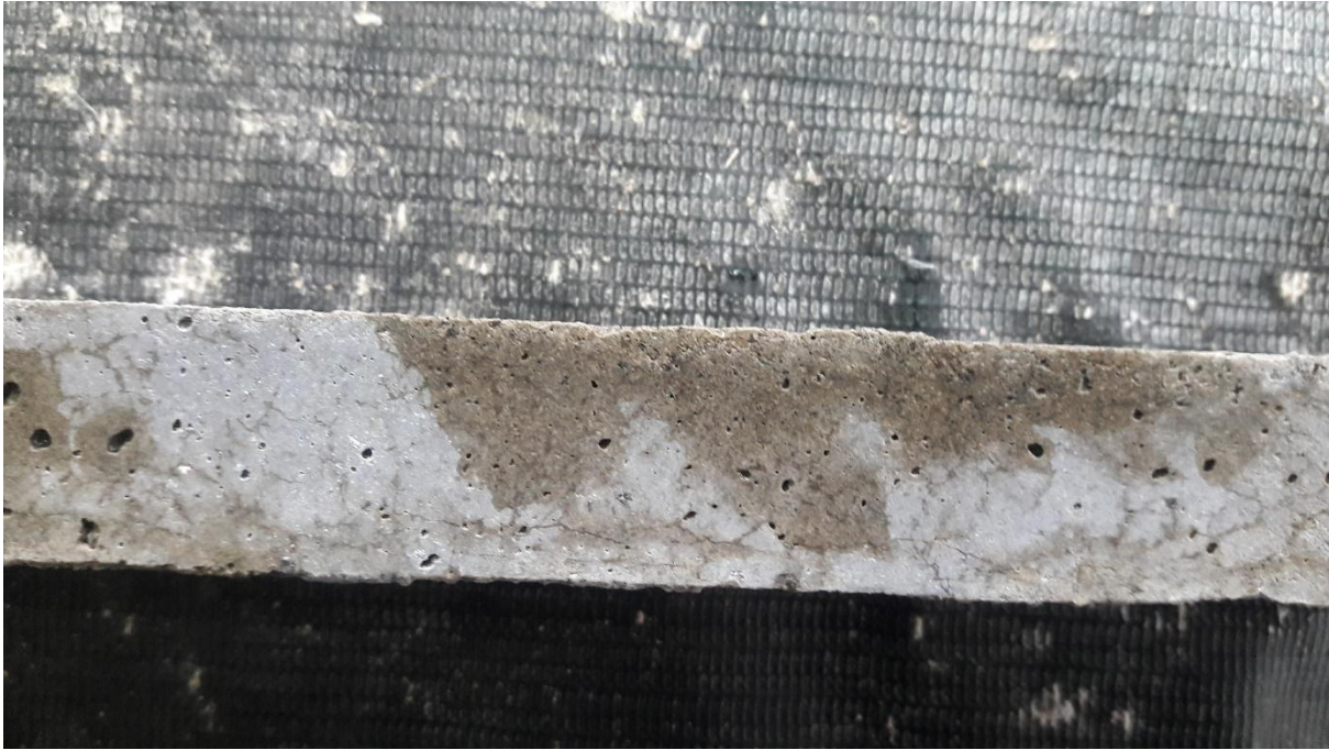
Figura 14 Fisuras en probetas con cemento GU y agregados de Cerro Negro
