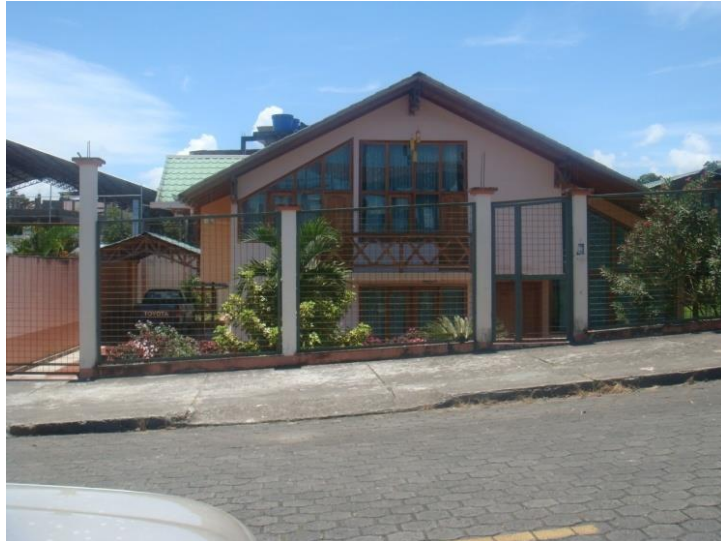
- Fotografía N° 7 Fachada estrato A.
