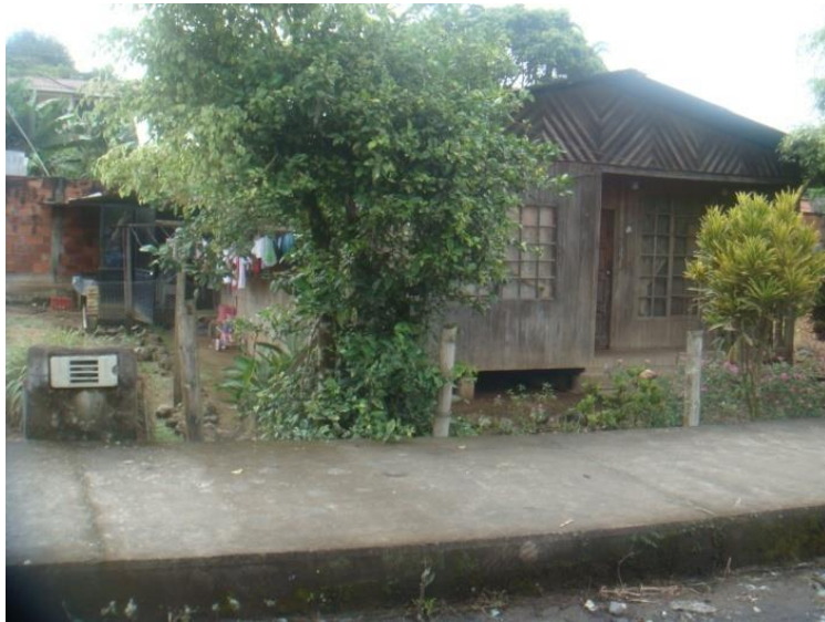
- Fotografía N° 9 Fachada estrato C.
