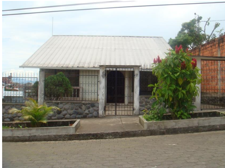
- Fotografía N° 8 Fachada estrato B.
