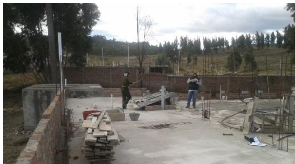
Figura 26. Medición de área de losa y aberturas.
