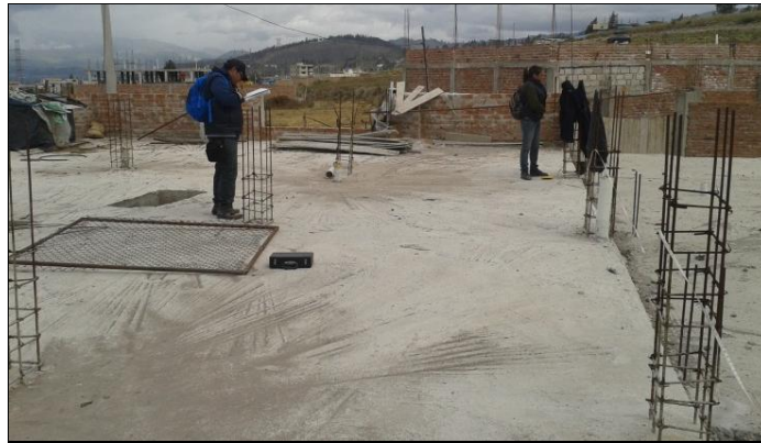
Figura 22. Levantamiento de datos de elementos estructurales.
