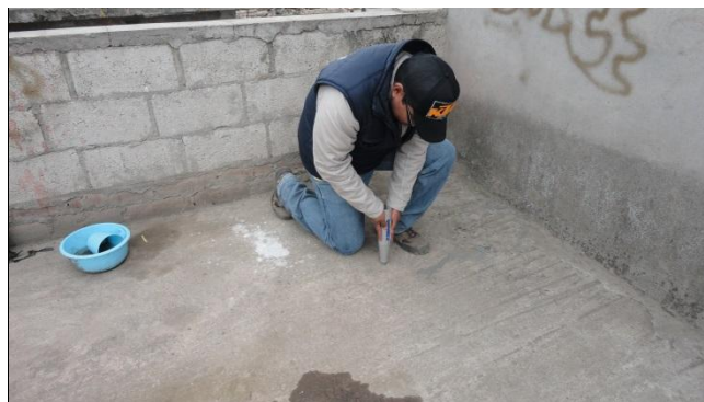
Figura 28. Ensayo De Esclerómetro +90 grados.
