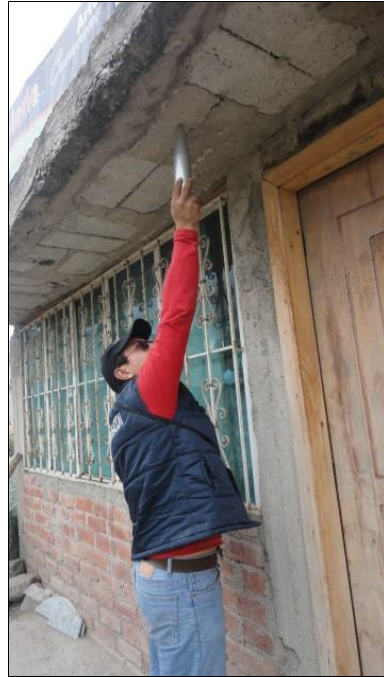
Figura 29. Realización del ensayo de esclerómetro -90 grados.
