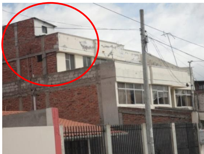
Figura 11. Ampliación informal de dos plantas adicionales.
