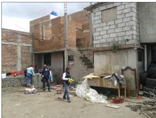
Figura 6. Vivienda de Construcción informal, Barrio Liribamba.
