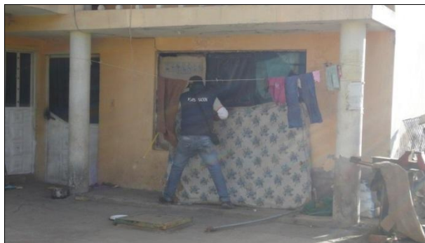
Figura 25. Medición de ventanas y ancho de mampostería
