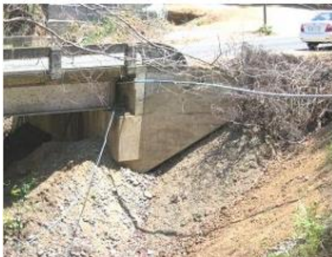
Figura 44. Relleno de aproximación.
