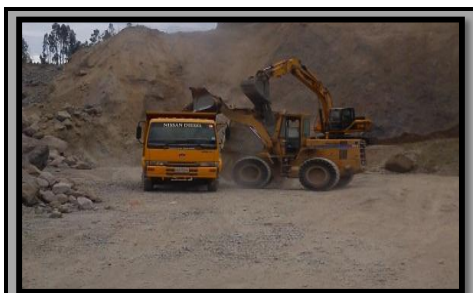
OBTENCIÓN DE LOS AGREGADOS A UTILIZAR EN CONCRETO CANTERA FLORES
