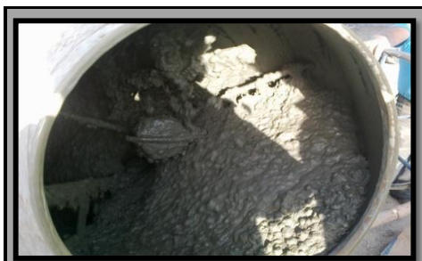
MEZCLADO DEL CONCRETO
