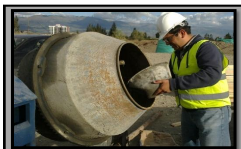
COLOCACIÓN DE MICROSÍLICE
